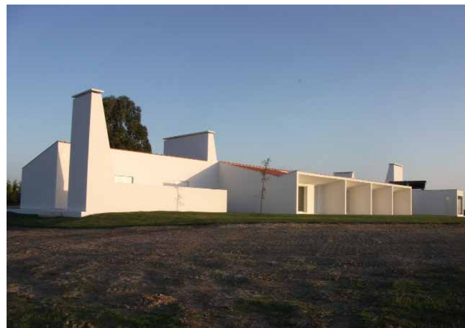
Construção de Herdade no Alentejo - Arqº Lourenço Rocchi
